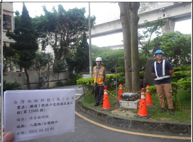
監測項目：環境噪音振動 監測日期：2024.04.03~04 監測地點：八德路/公園路口
